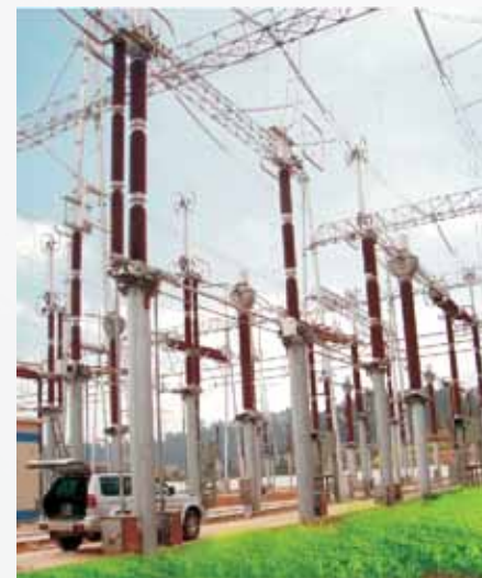
500kV ClassCT TYP 4000:1 Test result
